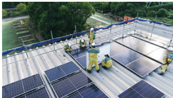
当社若手社員が直営作業にて太陽光パネルを設置
