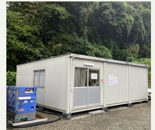
現地事務所の設置(2025年10月)
