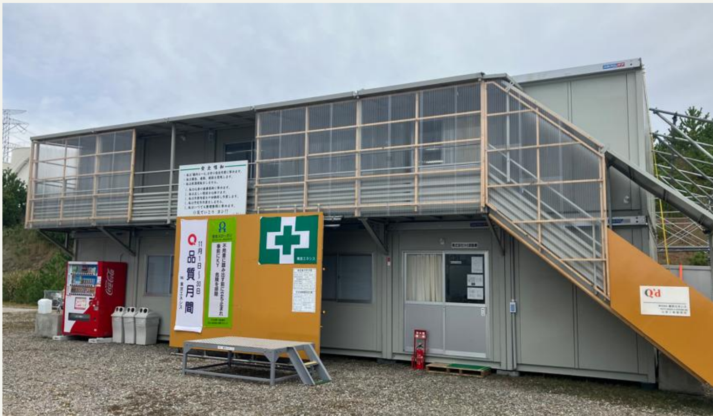
志賀工事事務所新設(2025. 09)
