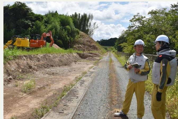
進入路の造成工事
