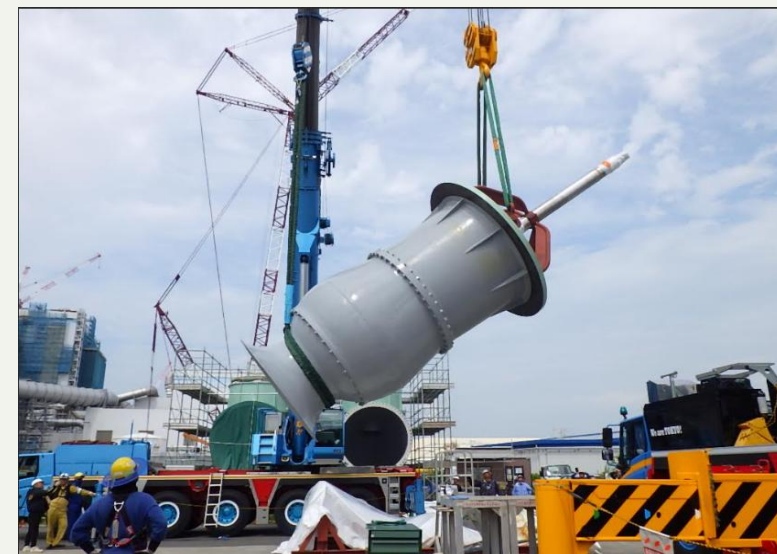
循環水ポンプ据付
